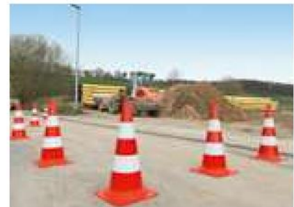
Baustelle ab Seite 140
