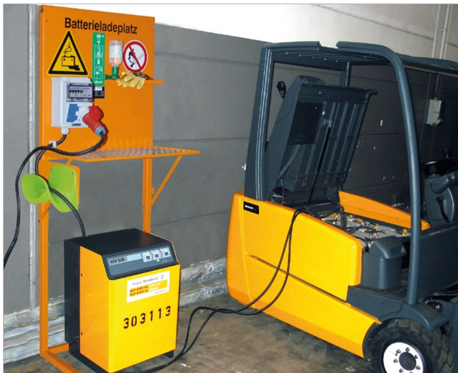
BL mit CEEform Steckdose 400 V beim Aufladen eines Elektro-Gabelstaplers
