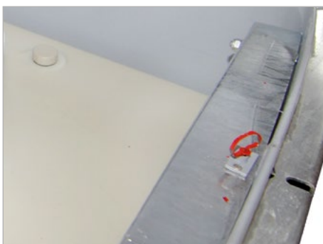
Peilstab für Leckagekontrolle
